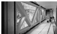
柱付鉄骨ブレース工法 (従来工法)
